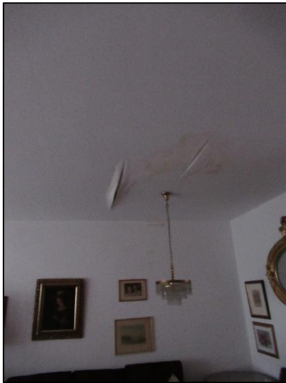
Feuchteschaden, Tappentenablösung
