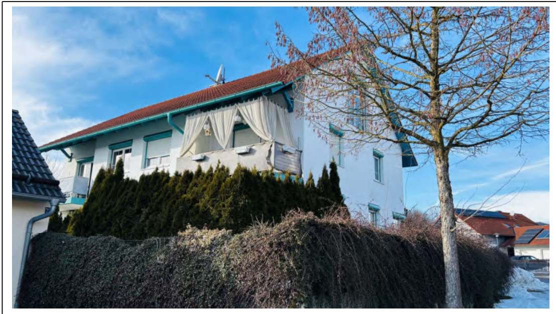
Foto 3: Ansicht von Osten
