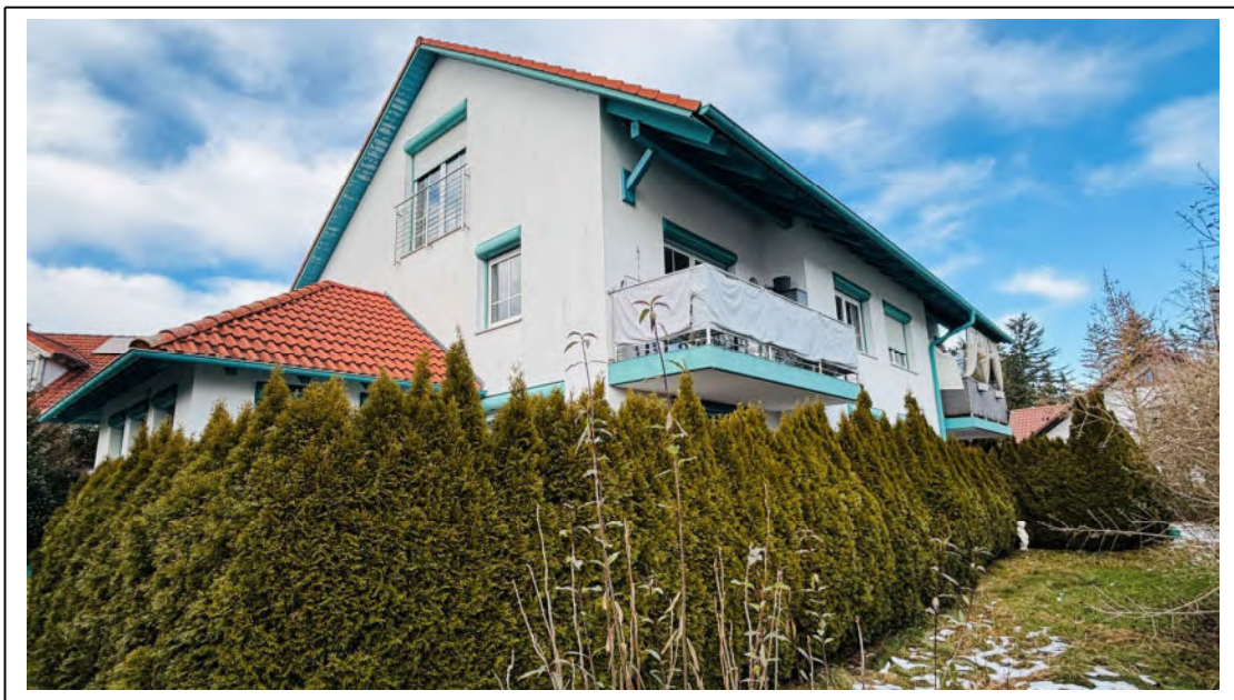
Foto 4: Ansicht von Südosten
