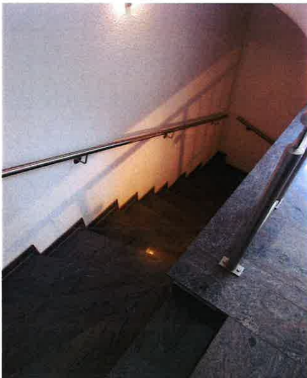
Treppe EG > KG
