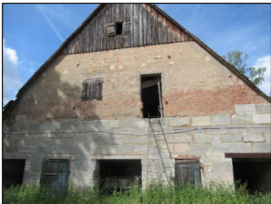
Scheune – Ansicht – Norden
