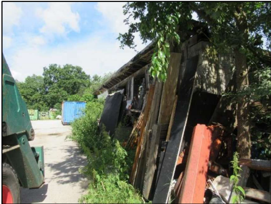
Remise – Ansicht – Osten
