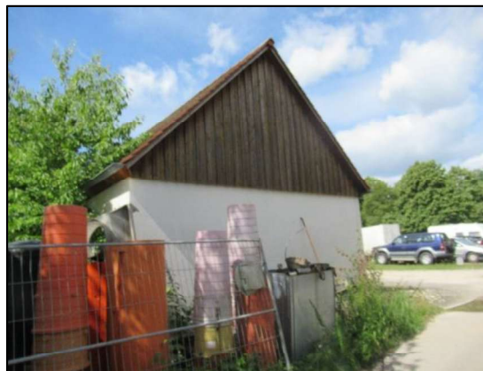
Garage – Ansicht - Norden
