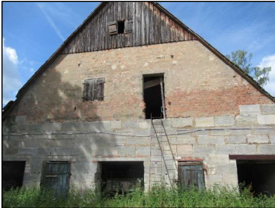
Scheune – Ansicht – Norden
