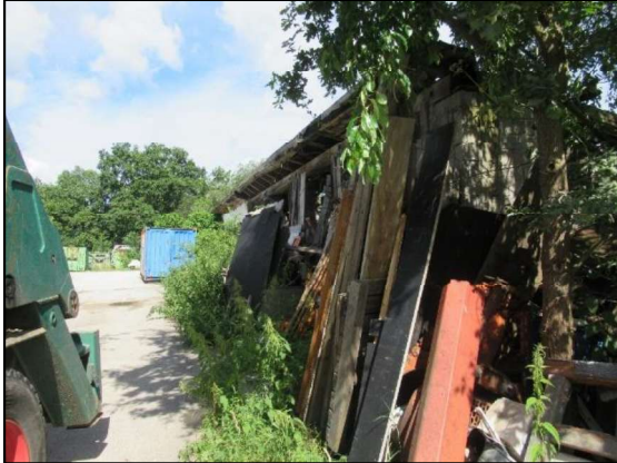
Remise – Ansicht – Osten
