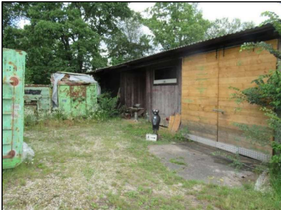
Remise - Ansicht – Süden
