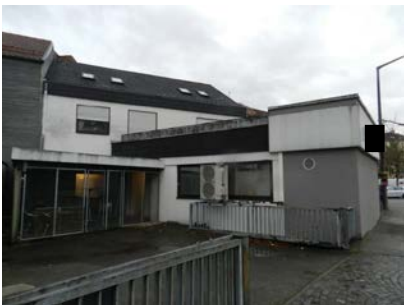
Ansicht von Nordwest
