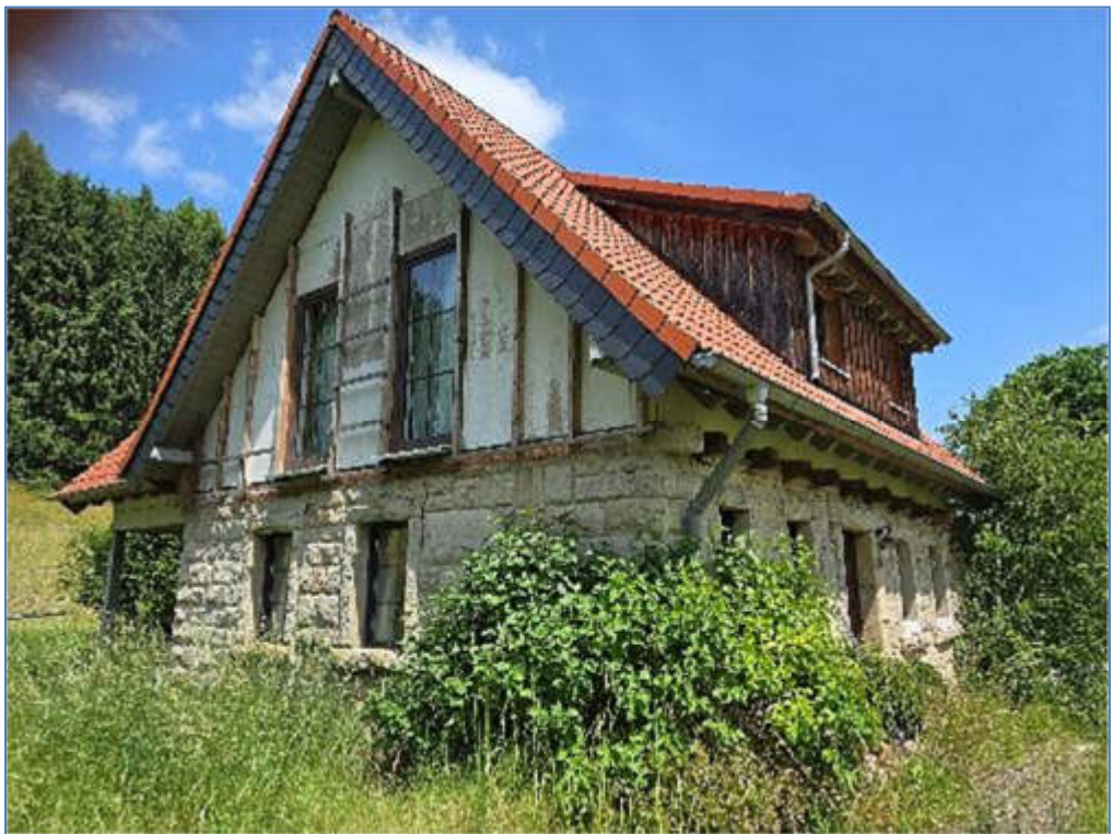
Bild 4 Pos. 01 Wohnhaus, West- und Südseite
