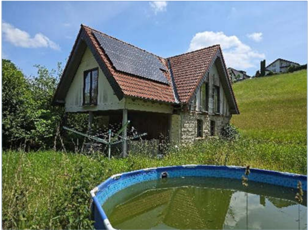
Bild 3 Pos. 01 Wohnhaus, Nord- und Westseite
