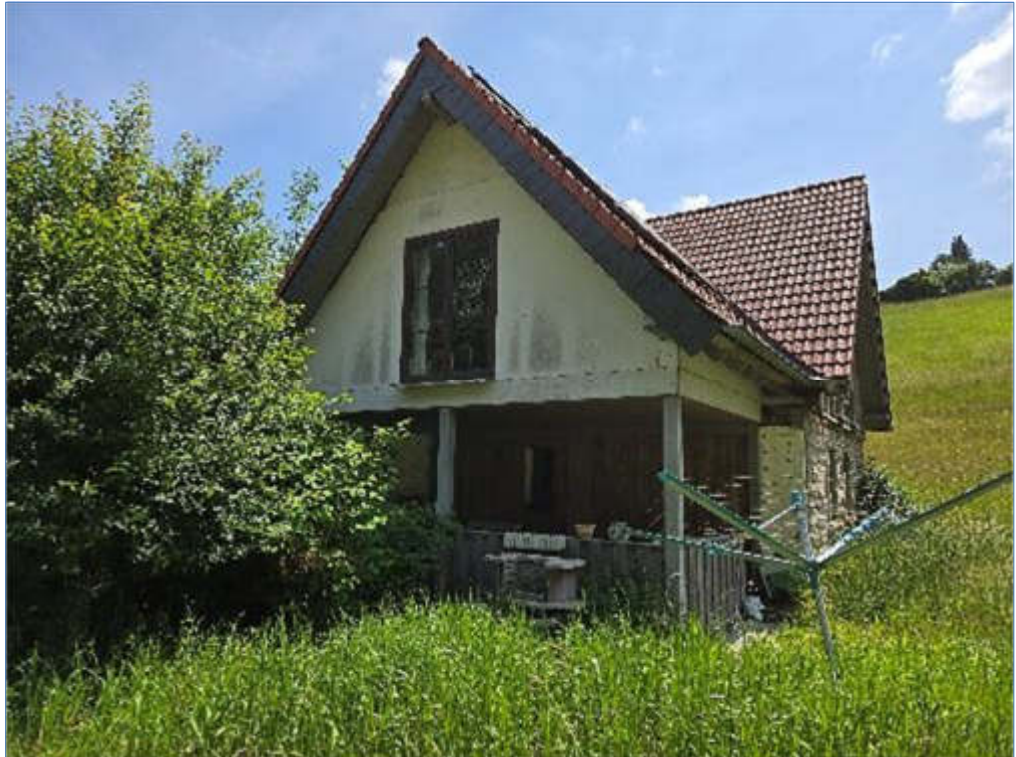
Bild 2 Pos. 01 Wohnhaus, Nordseite
