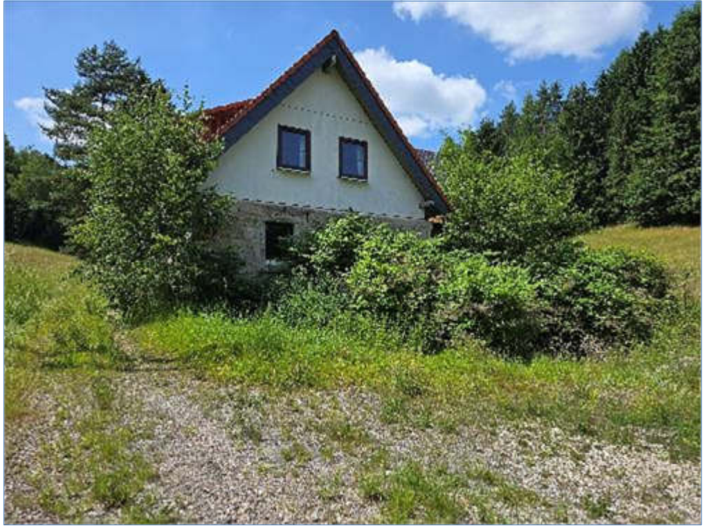
Bild 1 Pos. 01 Wohnhaus, Ostseite
