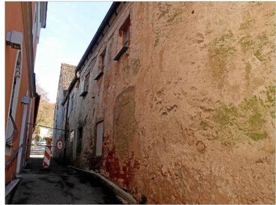
Ansicht Durchgang Kolpingstraße
