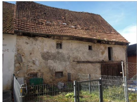
Ansicht von Osten: Scheune
