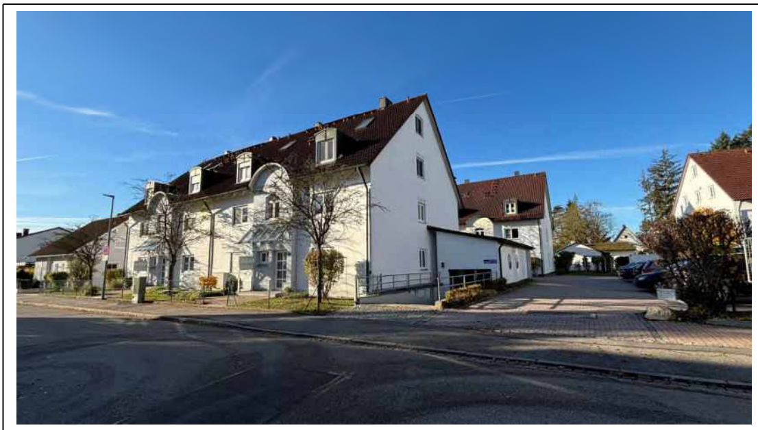
Foto 1: Wohnanlage - Ansicht von Nordosten
