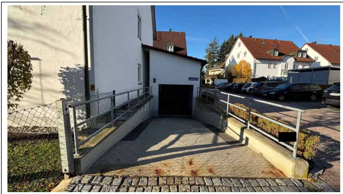
Foto 6: Zufahrt Tiefgarage - Ansicht von Osten
