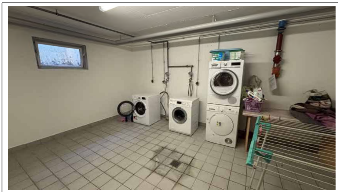
Foto 22: Blick in den Waschraum
