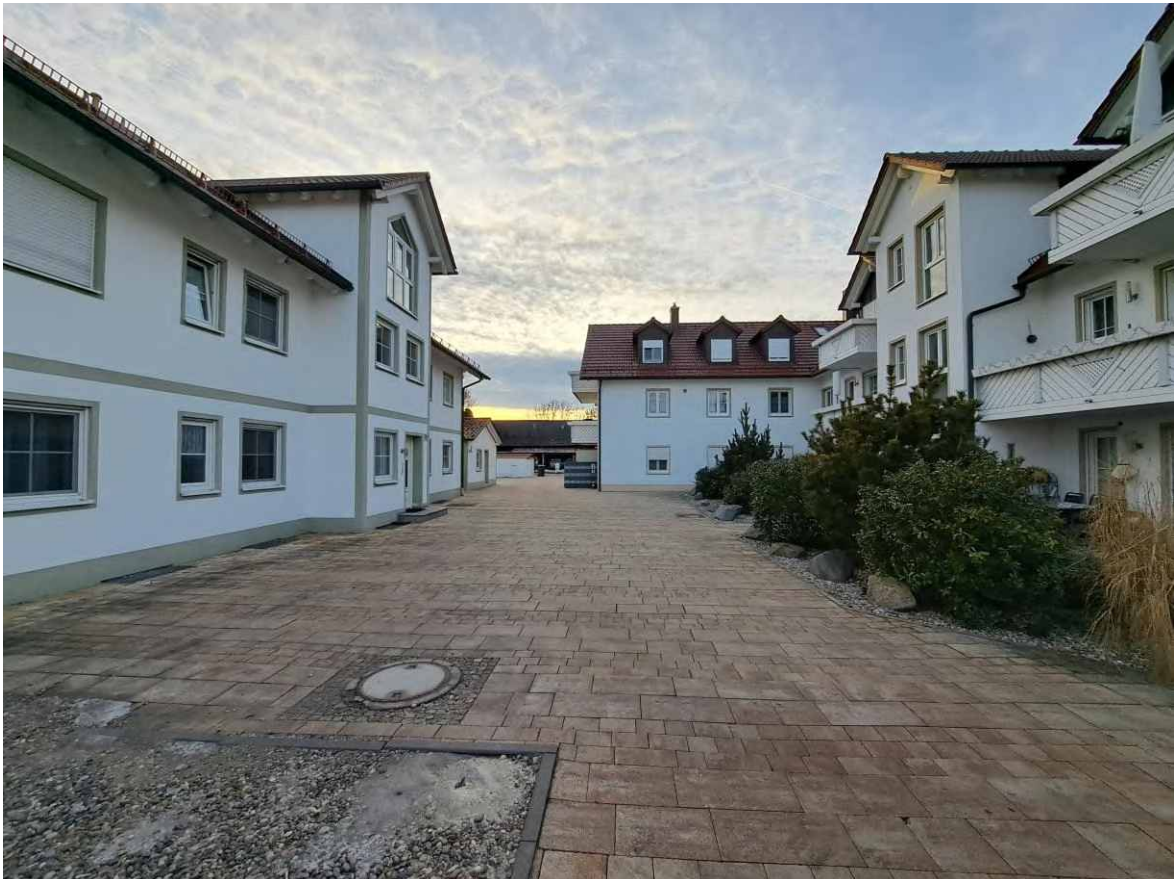
10 Zufahrt zum Grundstück über Nachbargrundstücke (Geh- und Fahrrecht)
