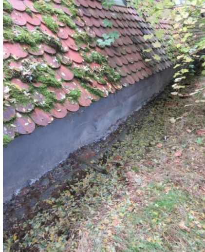
nordseitig Dachdeckung erneuern und entwässern
