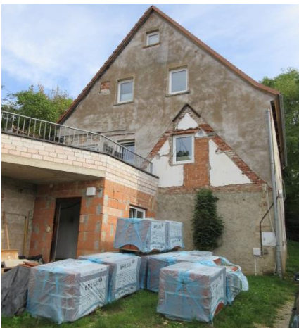
Außenfassaden dämmen und verputzen
