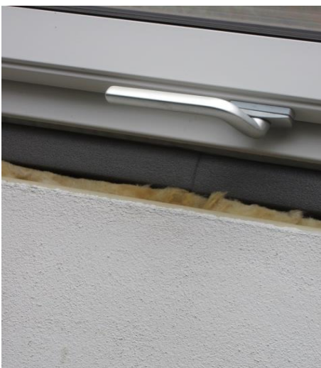
Restarbeiten in den Whg. OG und DG, z. B. Einputzarbeiten
