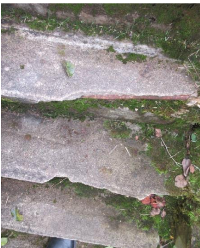
Außentreppe und Terrassenentwässerung erneuern
