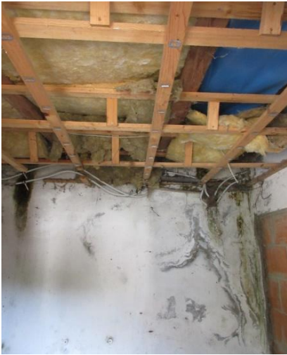
undichtes Flachdach beim Kellerersatzraum im OG
