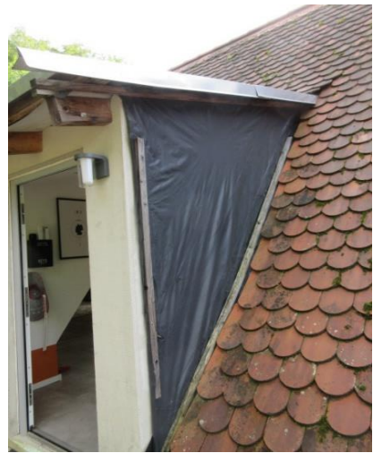
beim Wohnungseingangselement DG Seitenteil verblechen oder verglasen
