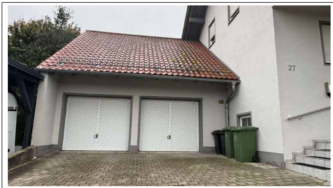
Foto 3: Doppelgarage - Ansicht von Westen
