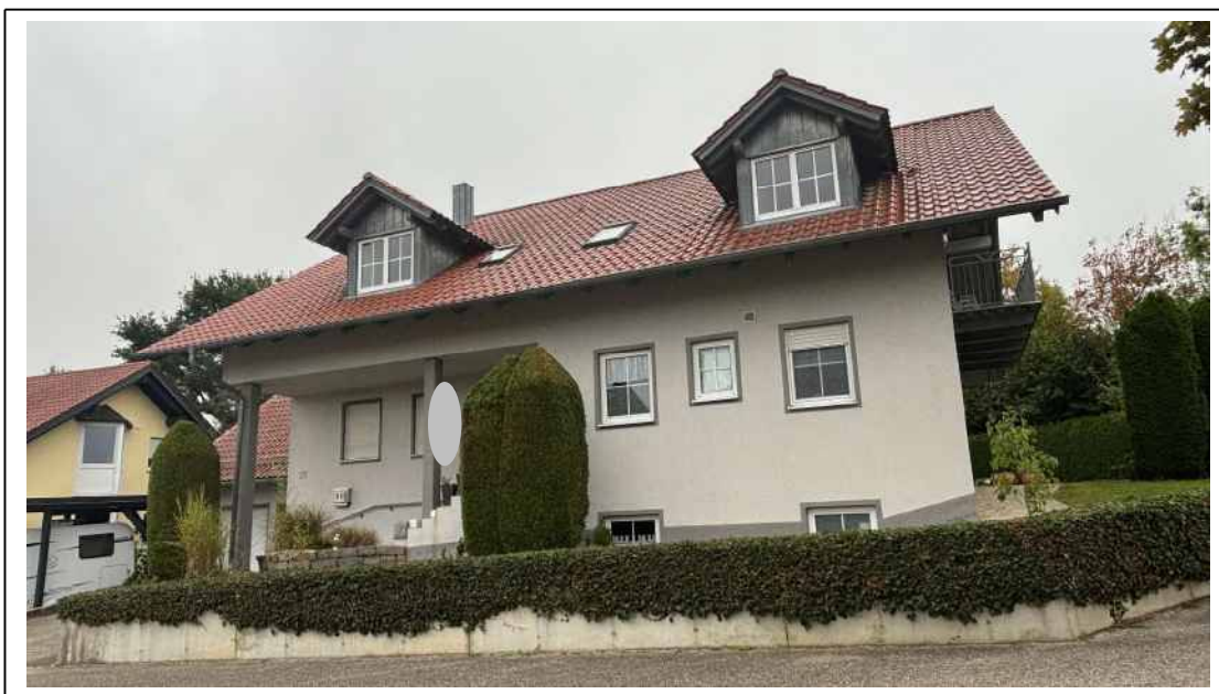
Foto 2: Ansicht von Westen
