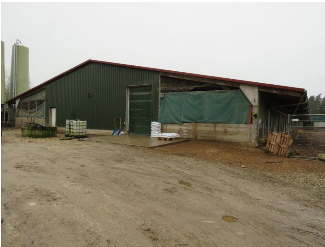
Abbildung: Ansicht des Gebäudekomplexes von Osten
