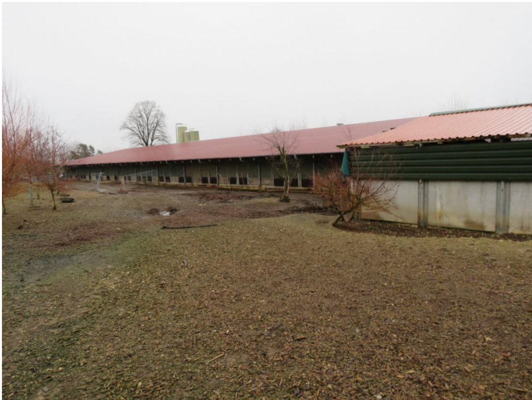
Abbildung: Ansicht des Gebäudekomplexes von Norden
