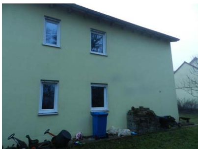
Ansicht von Norden
