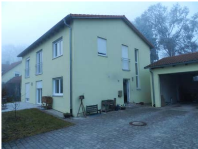
Ansicht von Südost
