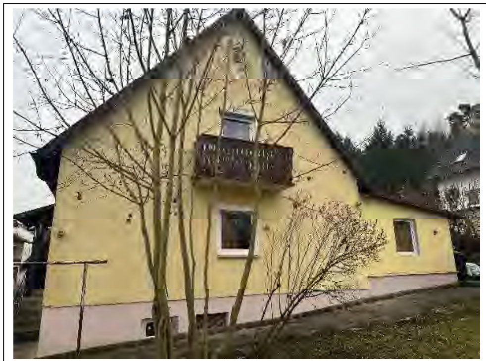
Foto 2: Ansicht von Westen
