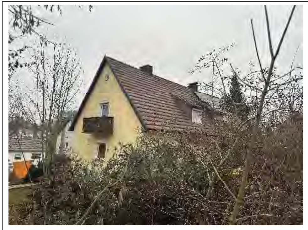
Foto 1: Ansicht von Südwesten
