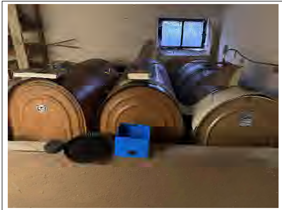
Foto 17: Blick in den Tankraum
