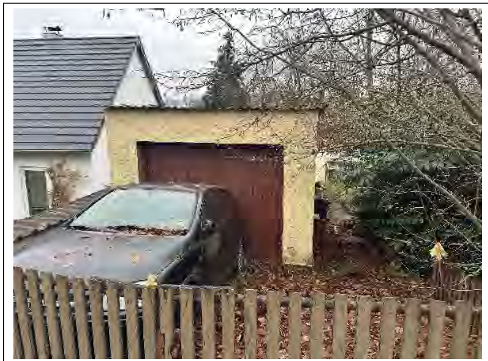
Foto 6: Garage – Ansicht von Süden
