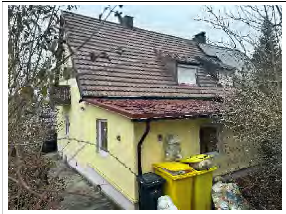
Foto 3: Ansicht von Südwesten
