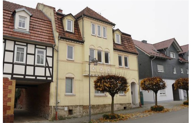
Blick von Südosten auf das Bewertungsobjekt
