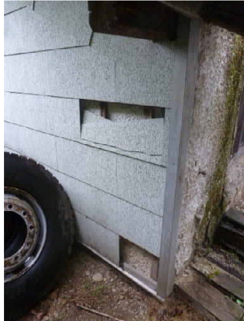
Blick auf die beschädigten Faserzementplatten des Wohnhauses Kolpingstraße 9
