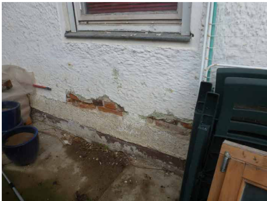
Blick auf die Feuchtigkeits-/ Putzschäden an der Südfassade des Wohnhauses Kolpingstraße 9
