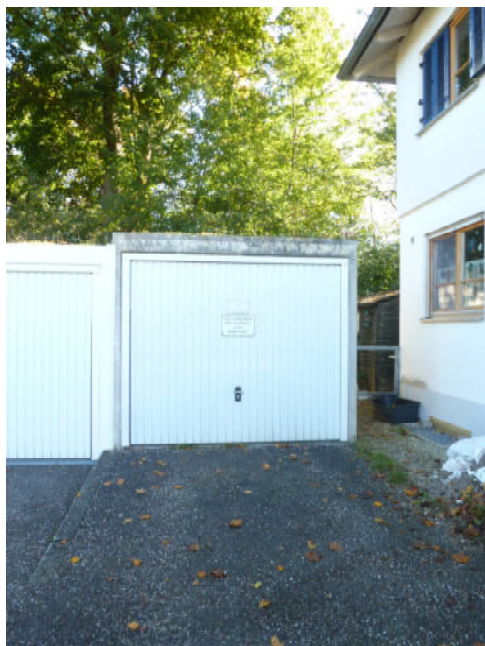
Westfassade Garage auf Flst. 718/30
