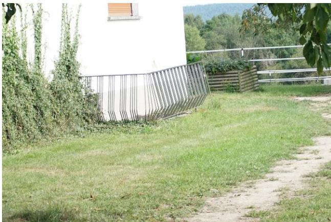
Kellerzugang an der Südwestfassade
