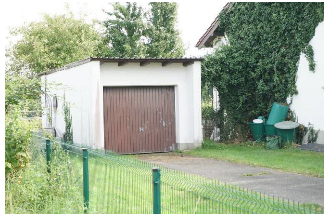
Garage im östlichen Grundstücksbereich
