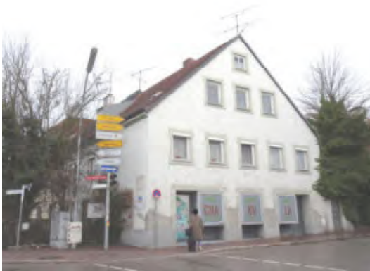
Südost- und Südwestseite des Gebäudes
