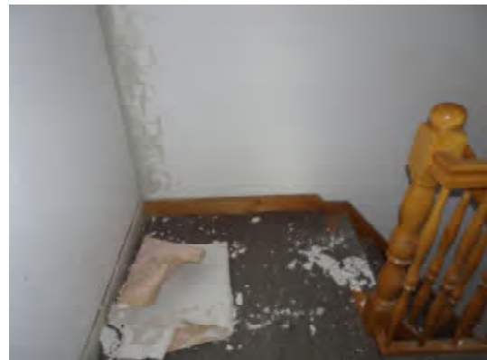
Feuchteschäden Treppenhaus
