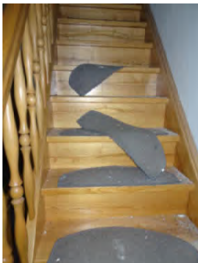
Treppenlauf zum DG
