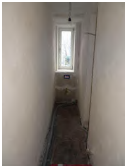
WC-Raum EG (nicht fertiggestellt)
