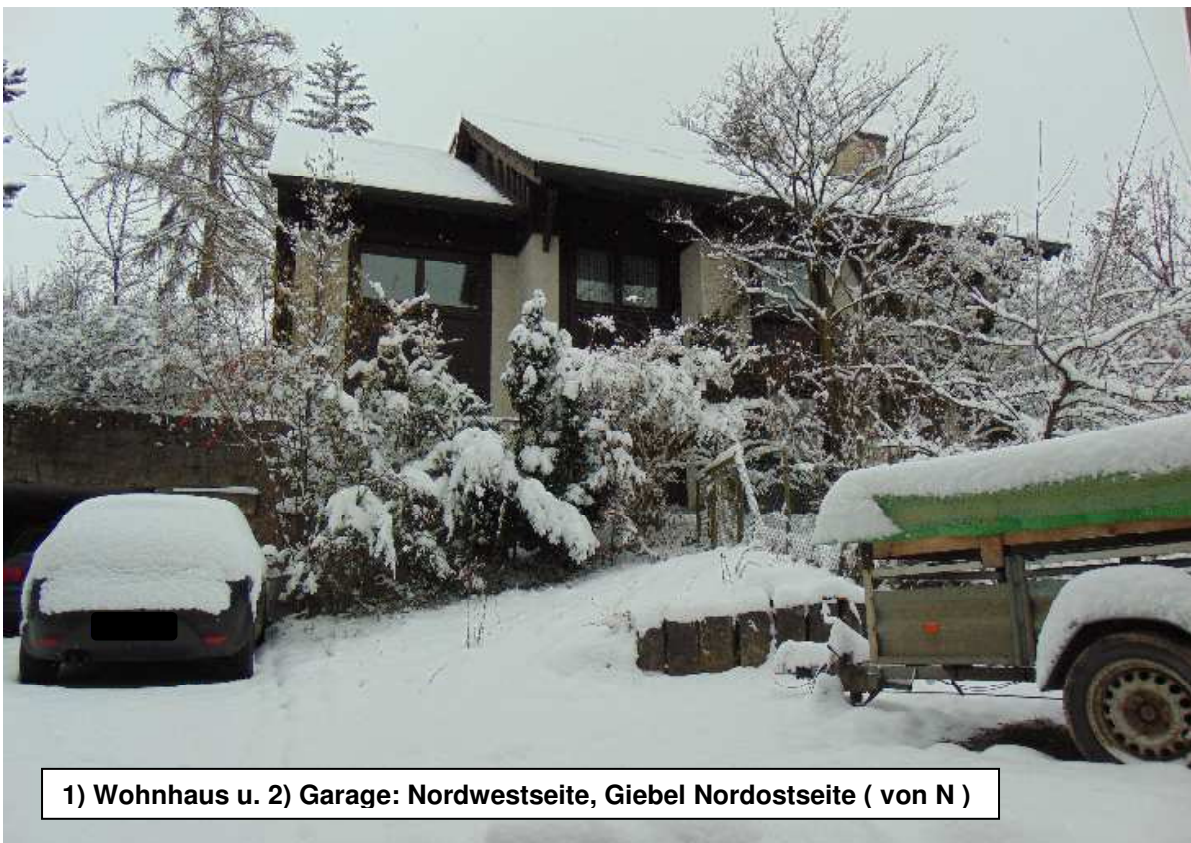
1) Wohnhaus u. 2) Garage: Nordwestseite, Giebel Nordostseite ( von NO )
