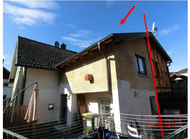
Blick von Nordosten auf das Bewertungsobjekt a) Doppelhaushälfte und Anbau
