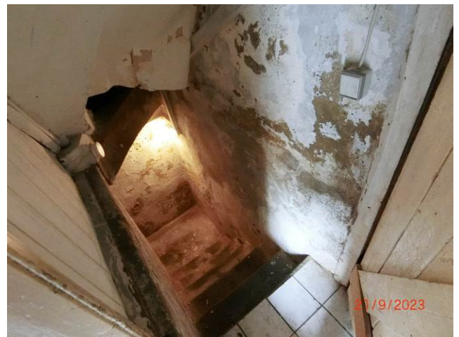
Treppe ins Kellergeschoss (Teilunterkellerung)
