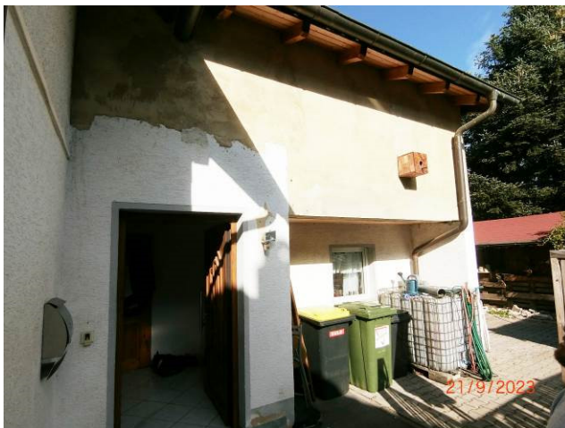
Hauseingang an der Südostfassade (Anbau)
