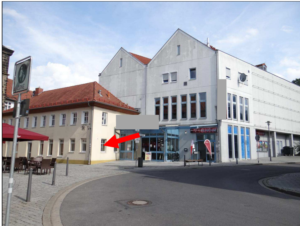
Bild 1: Blick auf das Geschäftsanwesen von Westen (SE-Nr. 4)
