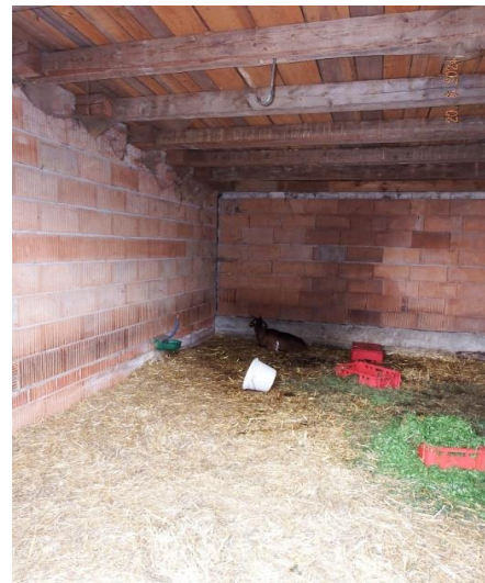
Sichtbare Holzbalkenlage mit Vollholzverschalung
