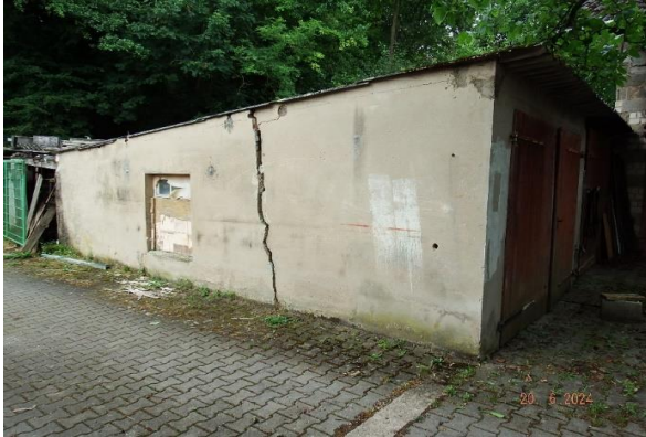
Sichtbare Wandrisse und die Dacheindeckung
