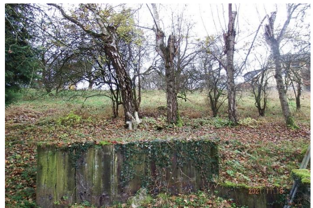
Stützwand aus Eichenbohlen und sichtbare Obstäume
