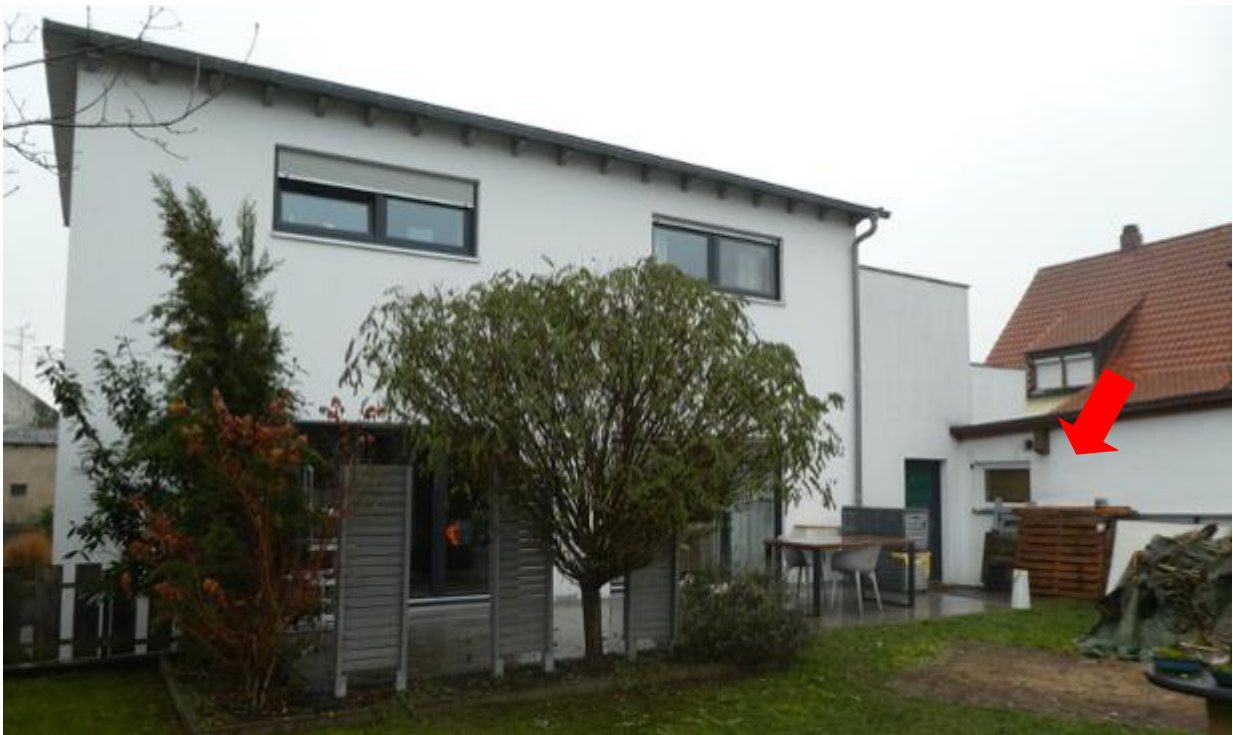
Ansicht Nord mit an das Wohnhaus herangebauter Werkstatt (siehe Pfeil) entlang Westflanke von Fl.-Nr.: 382/2.
