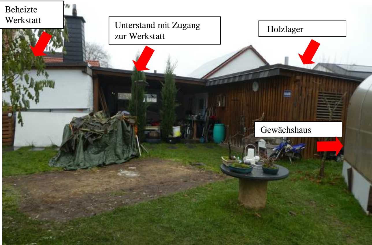
Gartenseite im nördlichen Abschnitt von Flurstück 382/2 mit Nebengebäuden wie beheizte Werkstatt, Unterstand mit Zugang zur Werkstatt, sowie Holzlager und Gewächshaus (siehe Beschreibung mit Pfeilen).
