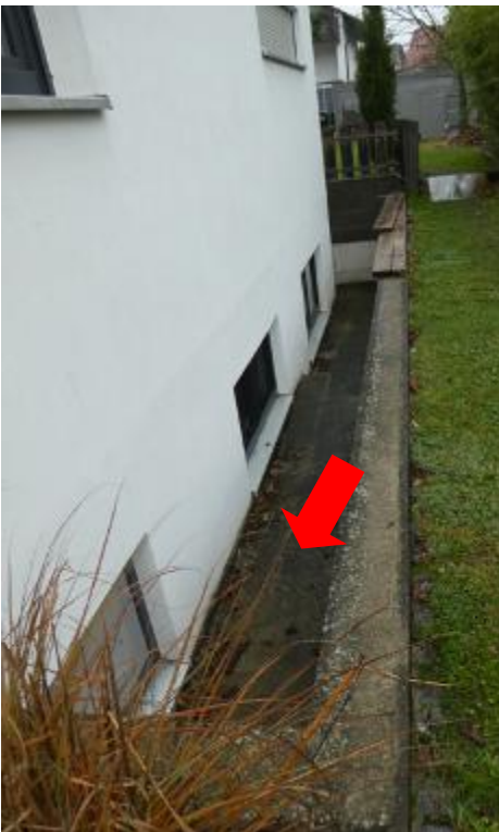
Lichthof entlang Ostflanke des Wohnhauses ósiehe Pfeil.
