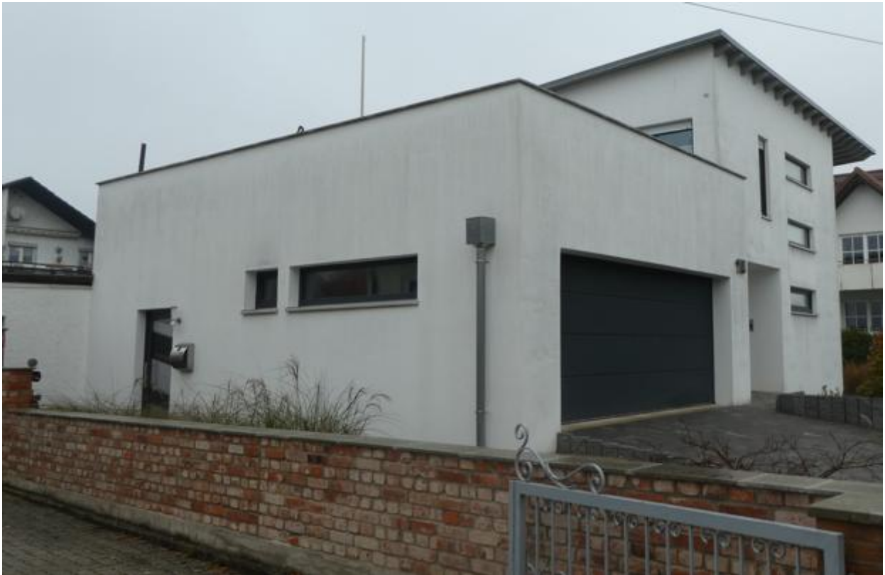
Ansicht West mit Zugang zur Einliegerwohnung im Keller.
