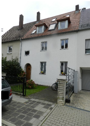
Ansicht von Nordwest
