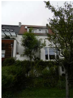
Ansicht von Südost
