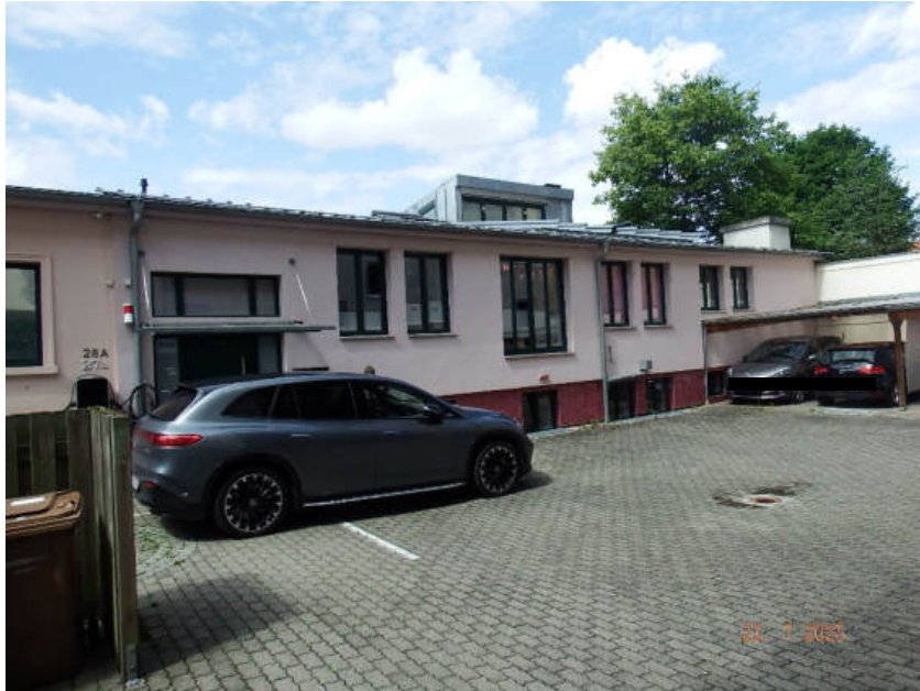
Gebäudeansicht „Heinrichsdamm 27a“ (gem. Aufteilungsplan Sondereigentum an Nr. 2A) mit Sondernutzung an Kfz-Stellplatz „H“ (das geparkte Auto steht entgegen der Markierung)
