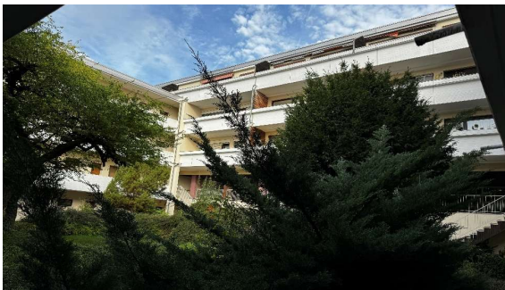
Ansicht vom Innenhof (Süd)
