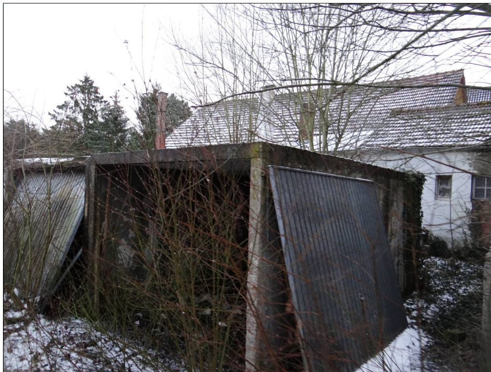
Nord-West-Ansicht der Fertiggaragen
