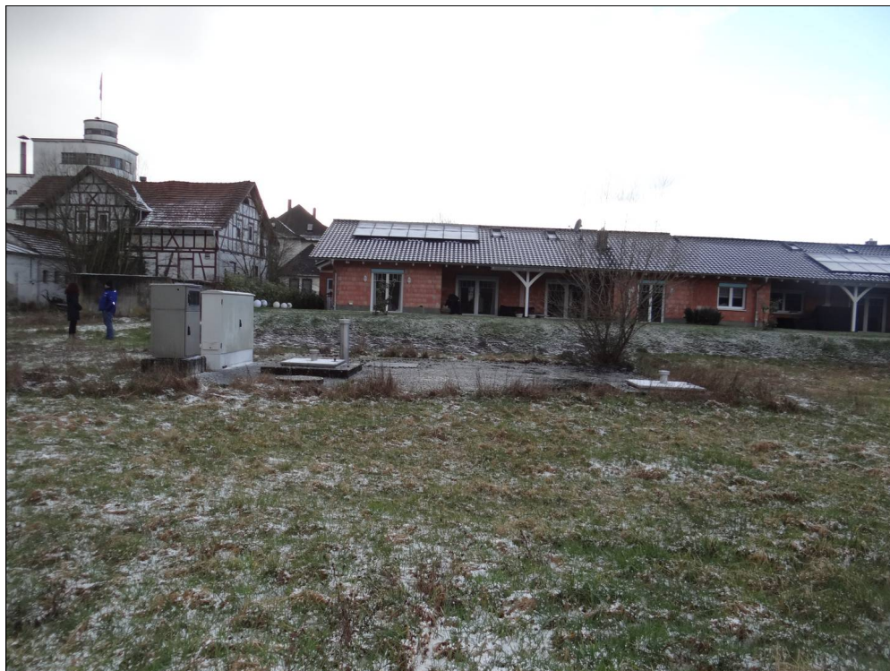
Blick von Osten auf den westlichen Bereich des Grundstücks FI.Nr. 71 (Speicher)
