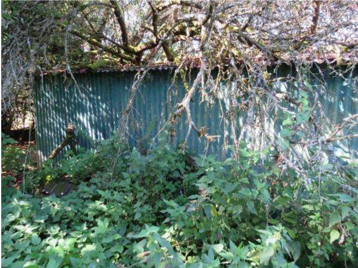
Abbildung 6 "Metallschuppen" auf Fl.Nr. 1546
