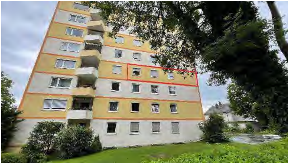
07 Angermaierstr. 53, Westansicht, die Bewertungswohnung ist rot markiert
