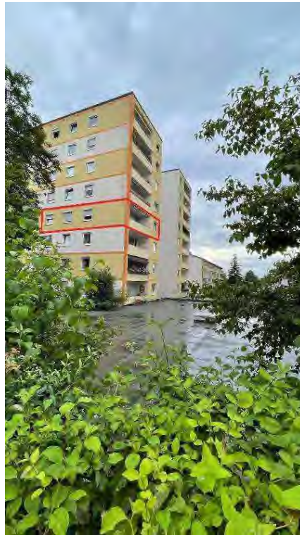
11 Angermaierstr. 53, Südwestansicht mit Blick auf das Garagendach, Bewertungswohnung rot markiert
