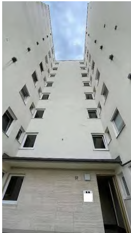
06 Angermaierstr. 53, Nordansicht mit Hauseingang
