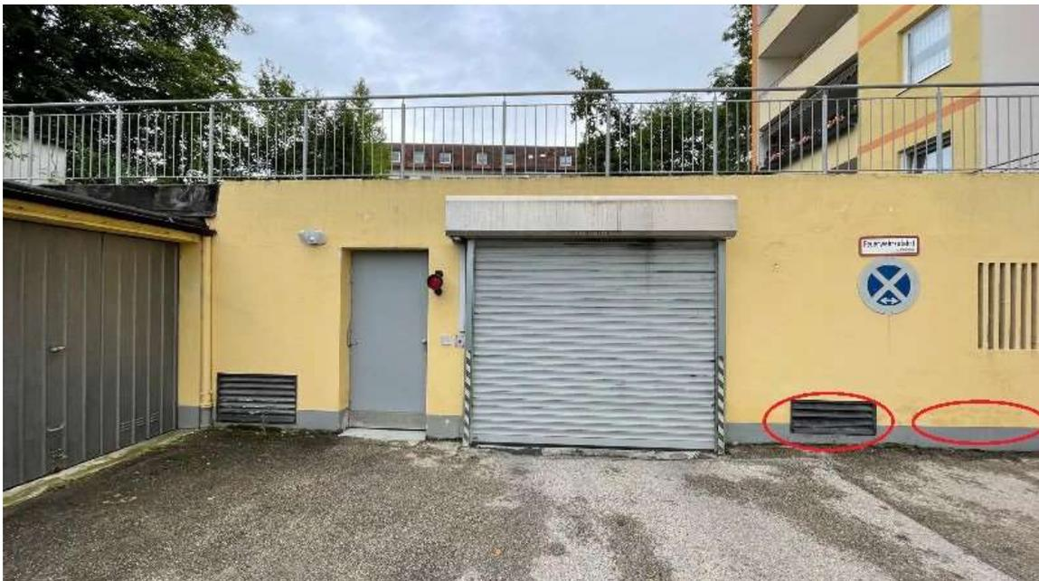
36 Garage, Blick auf die Ostfassade mit Zugangstor, verbogenes Lüftungsgitter und Nässe Spuren im unteren Drittel der Wand
