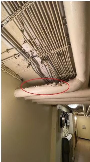
24 Angermaierstr. 53, KG, Beispiel beschädigte Isolierung Rohre
