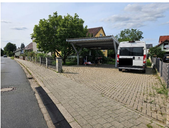
Grundstückszufahrt von der Frankenstr. + Carport
