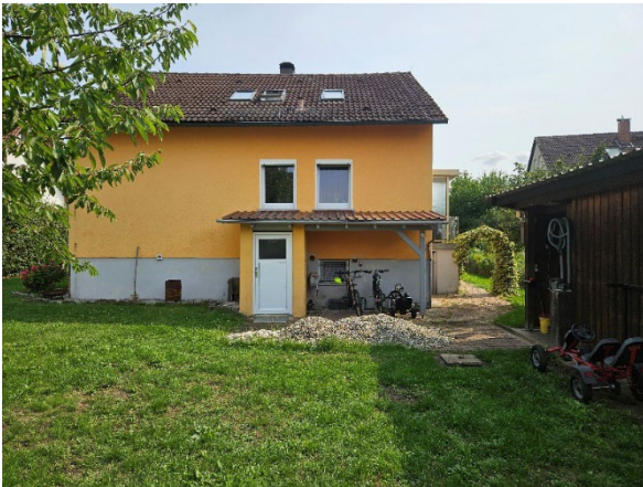
Rückansicht Bewertungsobjekt, (Nordseite)
