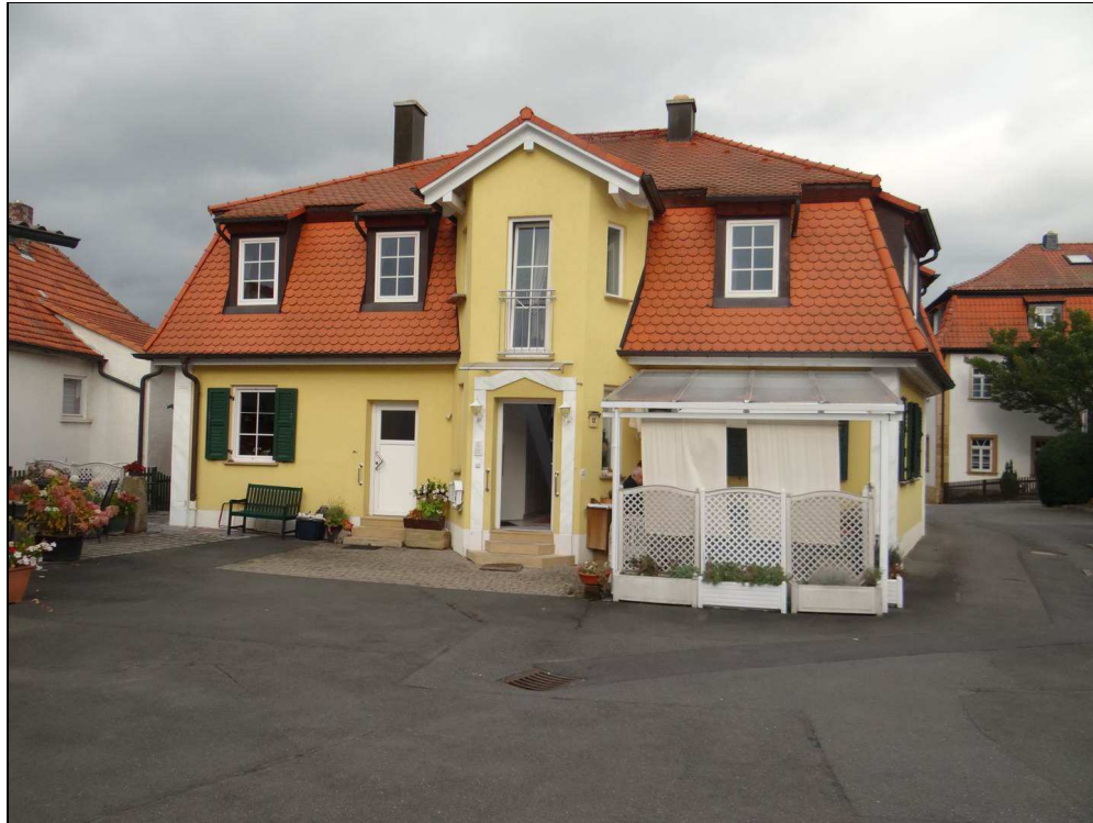
Bild 1: Blick auf das Wohngebäude von Süd-Westen
