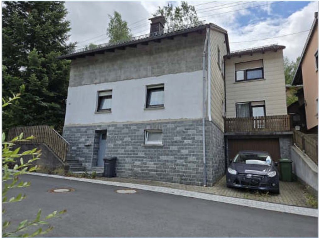
Bild 1 Pos. 01 Gesamtgebäude, Nordseite
