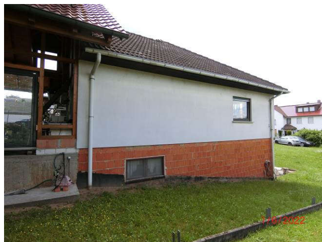
Blick von Nordwesten auf das Bewertungsobjekt b) Flst. 436/2 Wohnhaus
