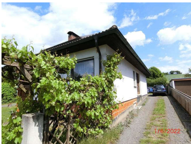
Blick von Süden auf das Bewertungsobjekt b) Flst. 436/2 Wohnhaus
