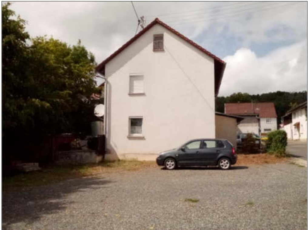
Bild 2 Pos. 01 Wohnhaus, Südseite
