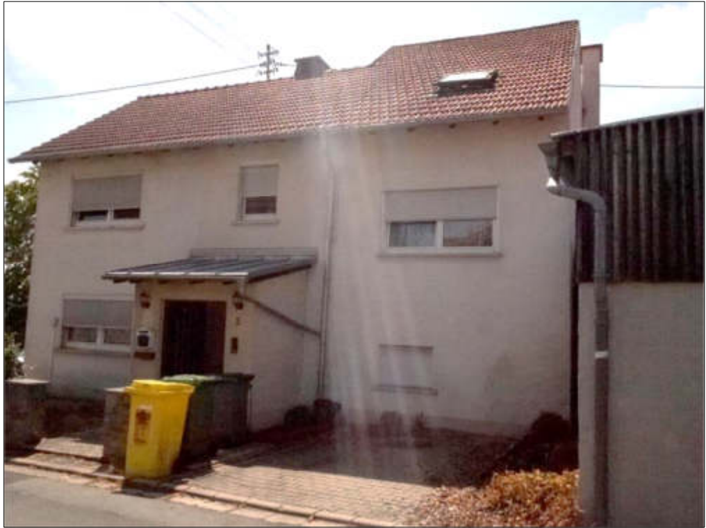
Bild 1 Pos. 01 Wohnhaus, Ostseite
