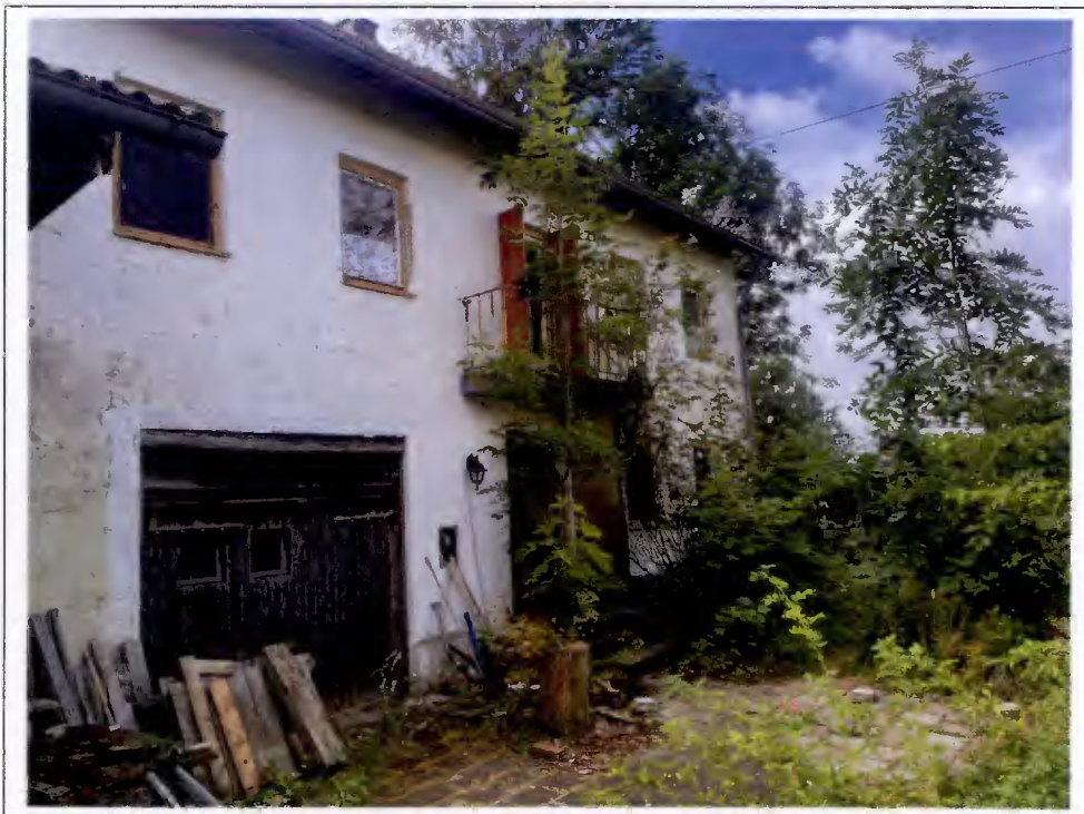
Foto 2: Ansicht von Nordosten
