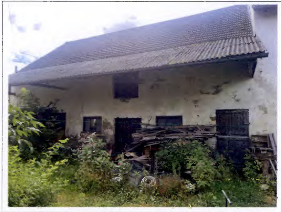
Foto 5: Stallanbau - Ansicht von Norden
