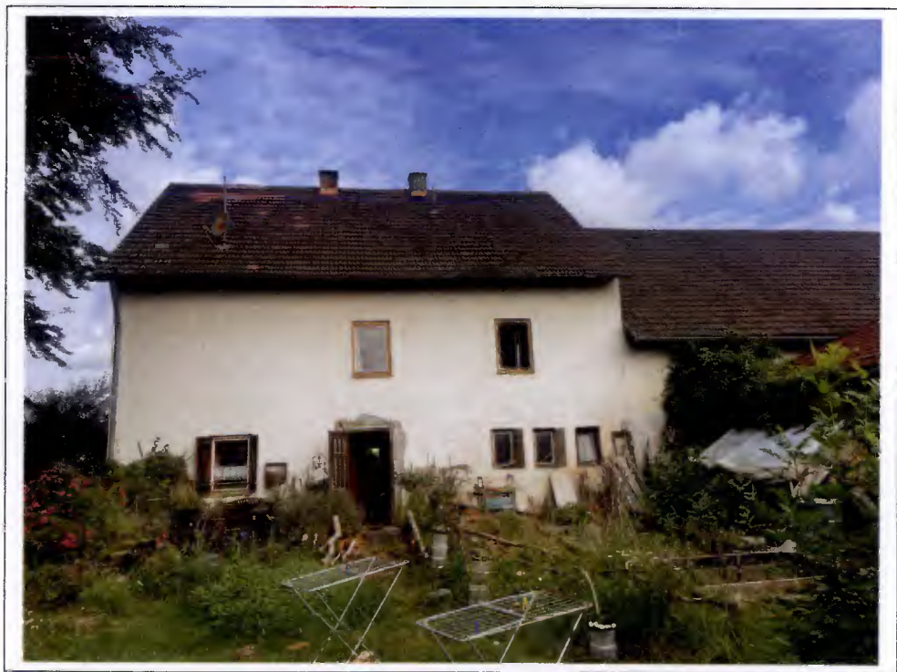
Foto 4: Ansicht von Süden
