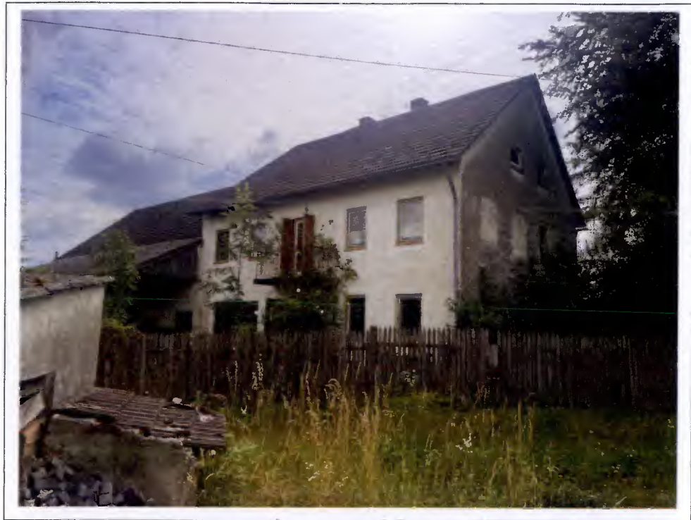
Foto 3: Ansicht von Nordwesten
