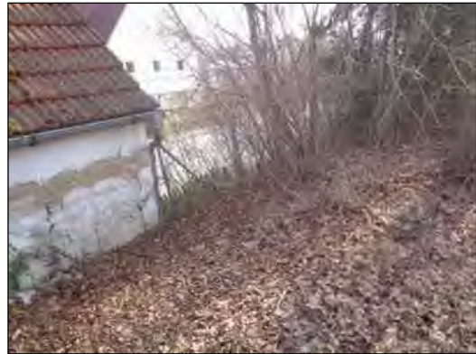
Angrenzende Hangböschung zu Moosburger Str.
