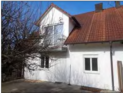
Südostfassade, Wohnung EG/ DG rechts
