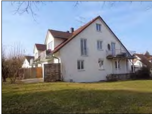
Rückseitiger Garten und Nordostfassade
