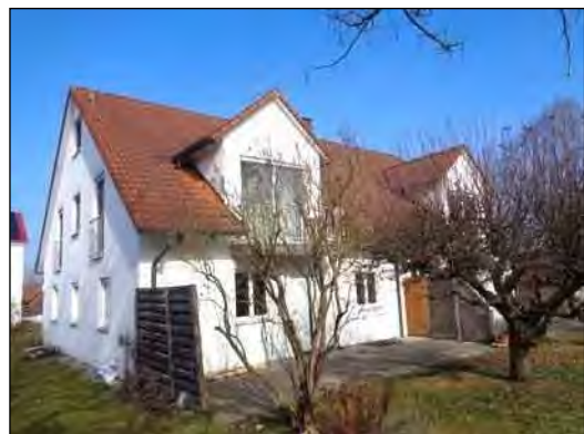
Südwest- und Südostfassade
