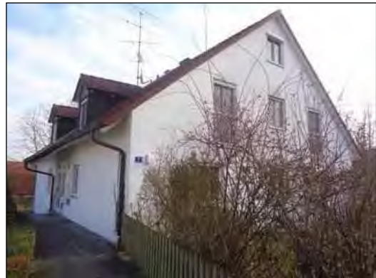
Nordwest- und Südwestfassade
