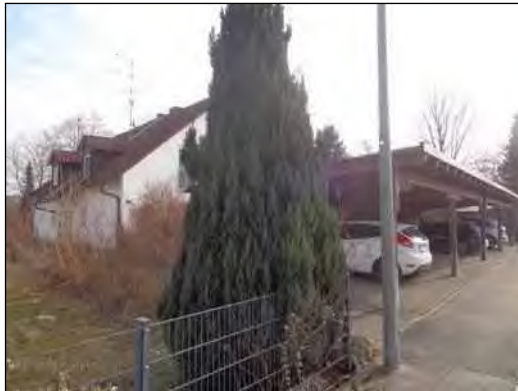
Bewertungsobjekt Hausnr. 7, Mehrfamilienhaus
