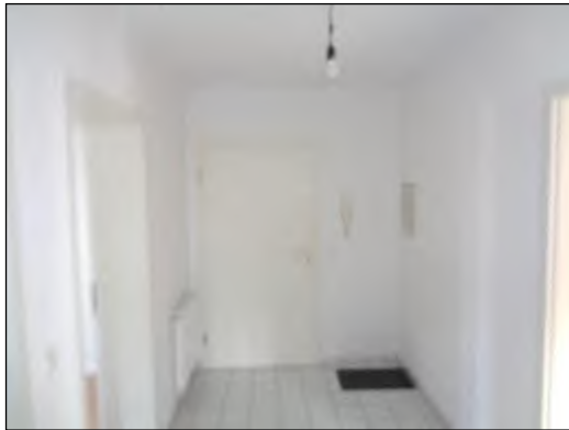
Wohnung EG rechts: Eingangsdielen
