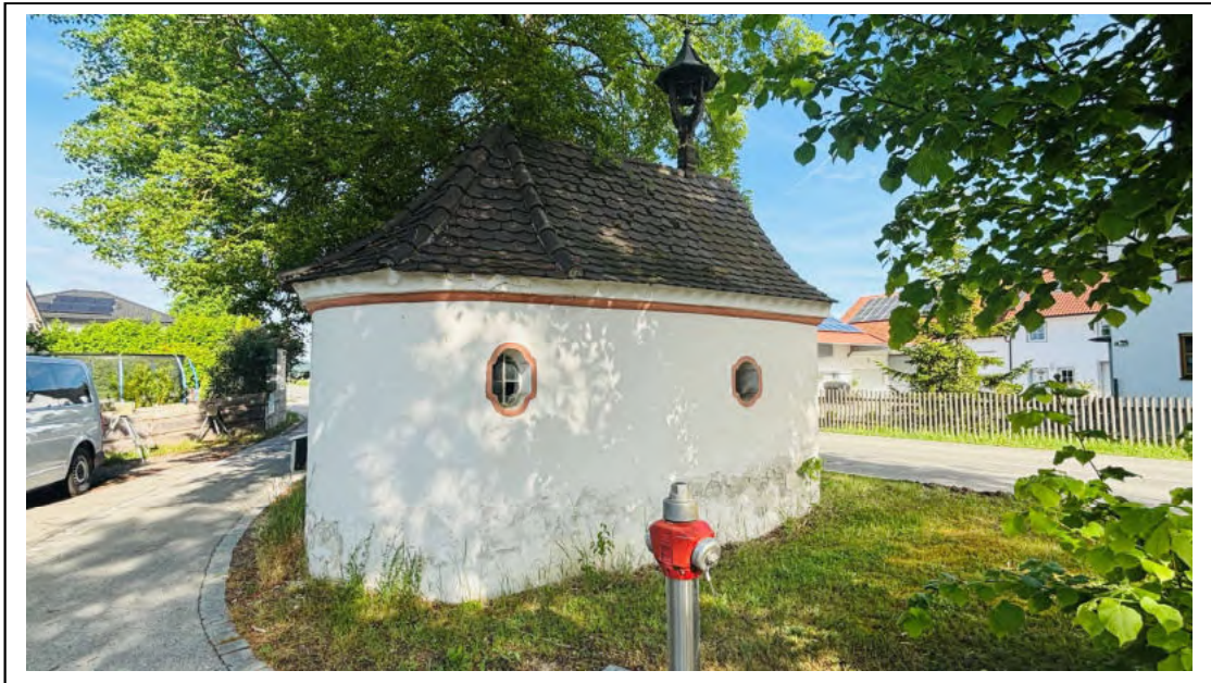
Foto 3: Kapelle - 1/11 Miteigentumsanteil an FINr. 183/13 - Ansicht von Südosten
