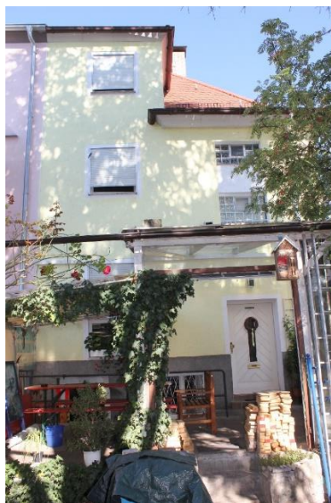
Südansicht mit Hauseingang
