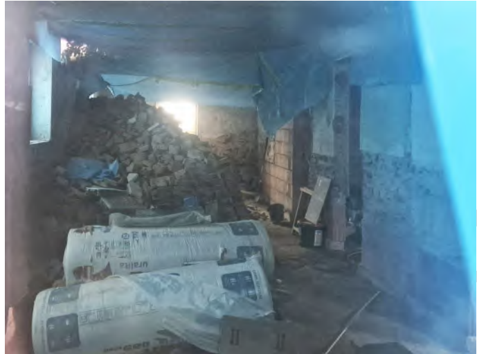
Einheit Erdgeschoss im Rohbauzustand
