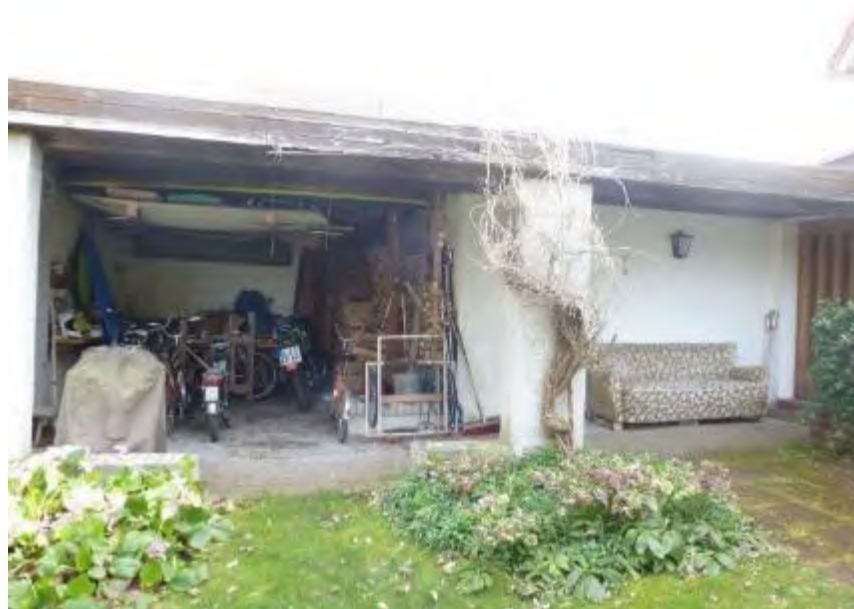
Blick von Südwesten auf das Nebengebäude
