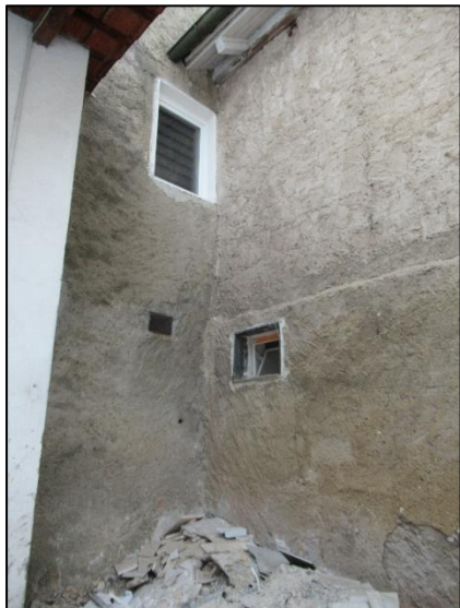
Feuchteschaden, Putz-/Farbabplatzungen
