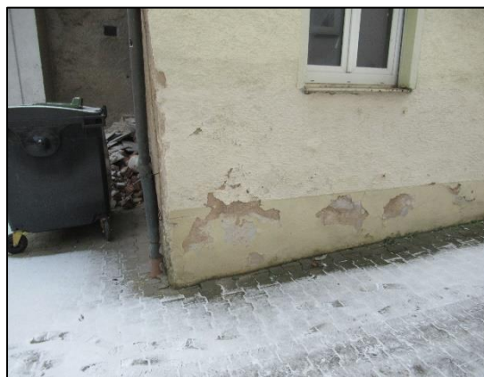
Feuchtesch., Putz-/Farbabplatzungen
