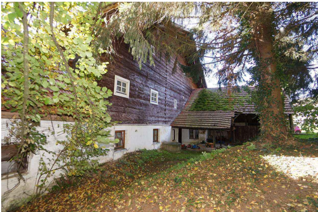
Bild 6: Das Wohnhaus – Gebäuderückseite von Nord-Osten her gesehen
