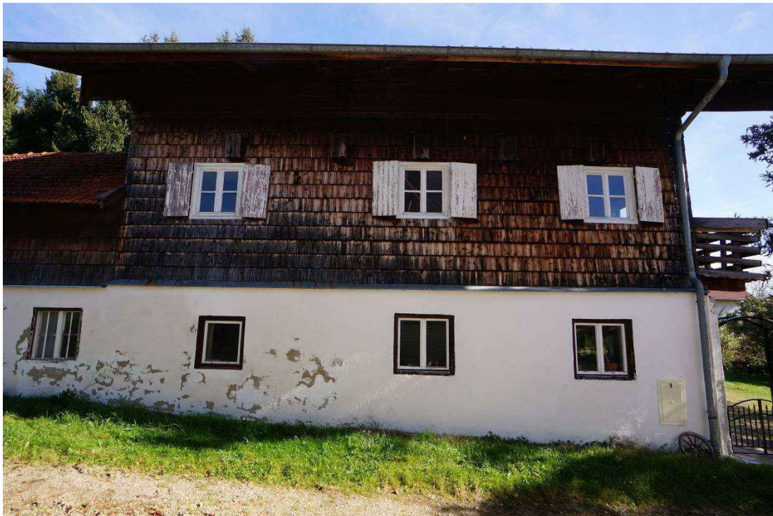
Bild 5: Das Wohnhaus Westseite
