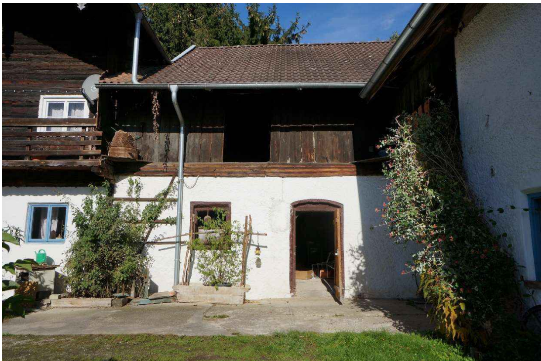
Bild 8: Das alte Stallgebäude angebaut an das Wohnhaus, Hofinnenansicht
