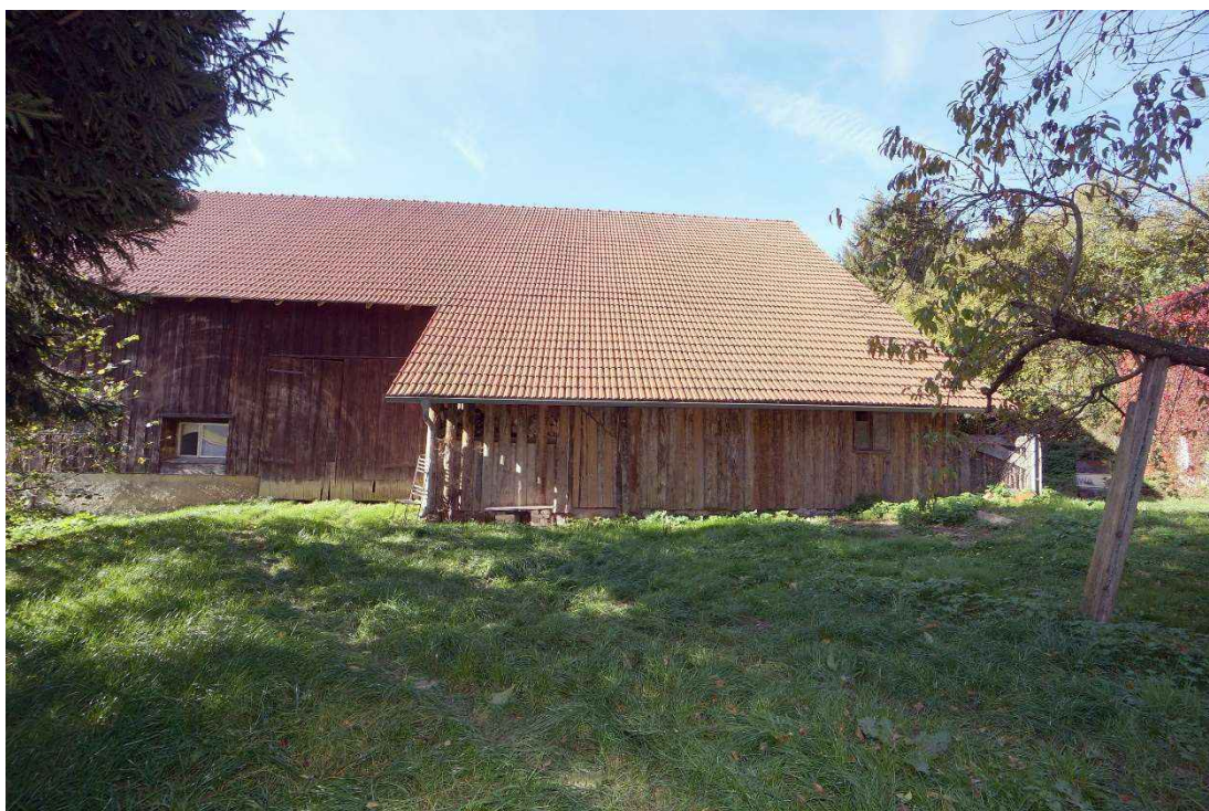
Bild 14: Die Scheune Rückseite, von Osten gesehen
