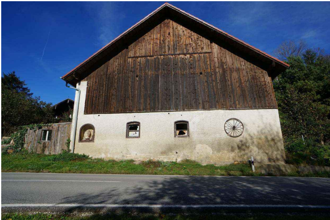
Bild 15: Die Straßenseite der Scheune - Südseite
