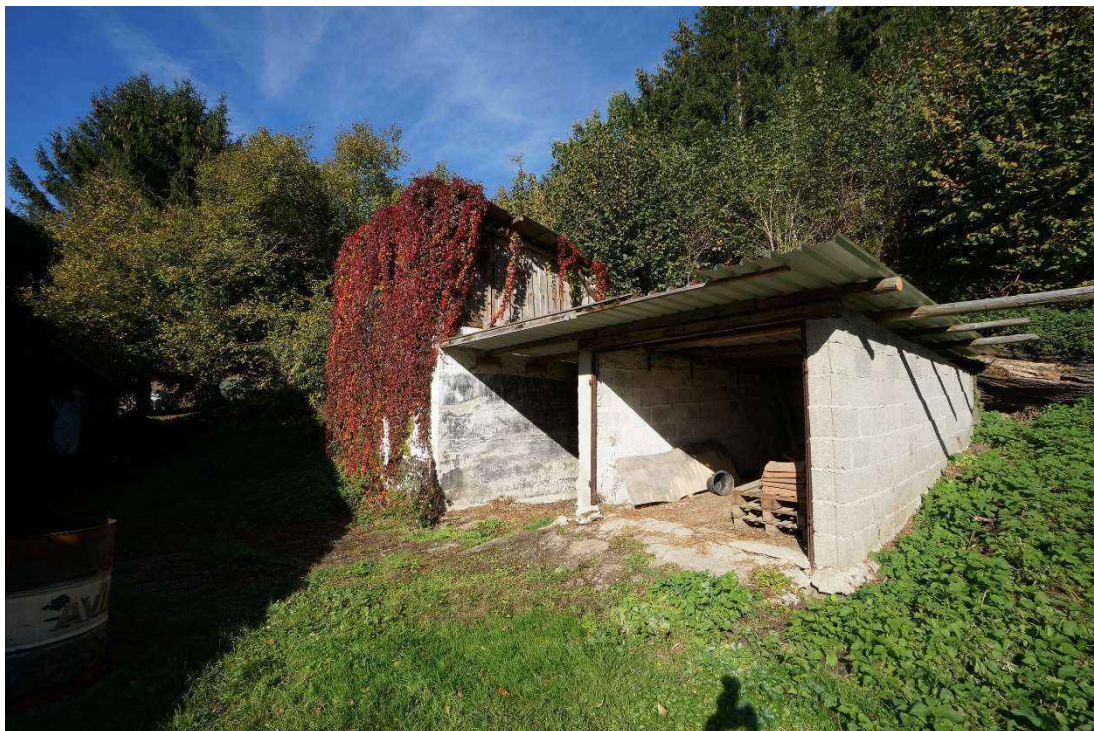
Bild 18: Die beiden Betonsteingaragen, dahinter mit altem gemauerten Hochsilo von Süd-Westen her gesehen
